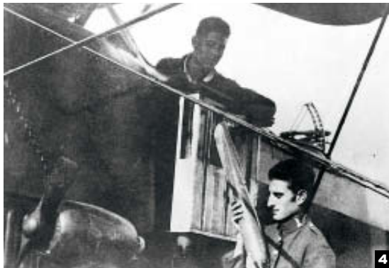
1. Vista aérea del TALLER DE GASES DE MELILLA para fabricar iverita. 2. Panorámica de las INSTALACIONES. 3. TANQUES en los que se preparaba la mezcla. 4. CARGA DE LOS PROYECTILES en el avión.
